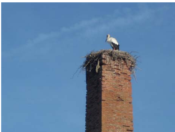
En stork har bygget rede på skorstenen på en nedlagt fabrik i Villa real santo Antonio
