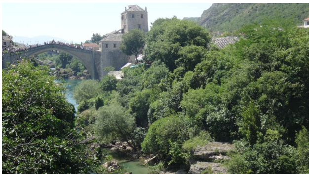
Den genopbyggede bro i Mostar
