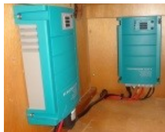
En 2x20 Ah Mastervolt 3 trins-lader (th), og (tv) en Mastervolt sinus-inverter
