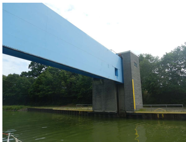
Et af de utallige "Sicherheitsthore", der af sikkerhedsmæssige grunde at isolere de enkelte kanalaflsnit
